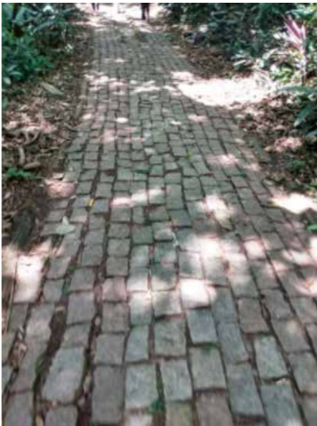
Piso irregular e trepidante executado em paralelepípedos no Parque Vila dos Remédios. Fonte: Fundação Aron Birmann.
