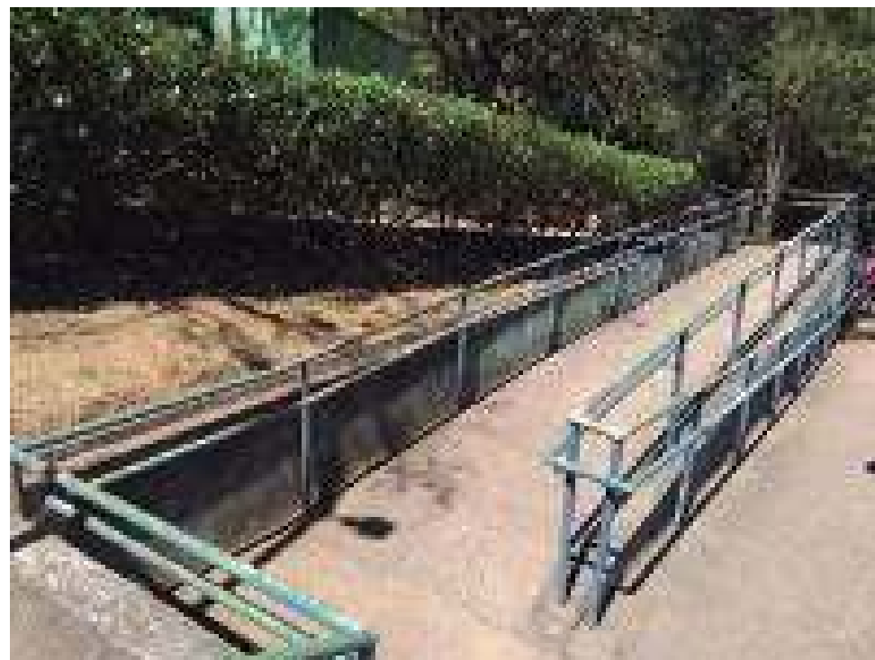
Rampas de acesso para PCD do Parque Senhor do Vale Fonte: Fundação Aron Birmann
