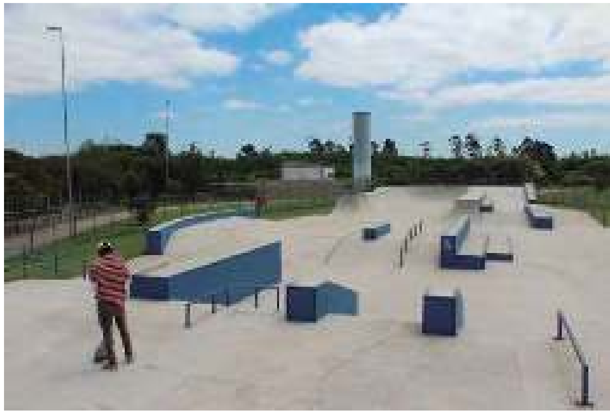
NÚCLEO DE LAZER VILA JACUÍ Fonte: Secretaria de Infraestrutura e Meio Ambiente
