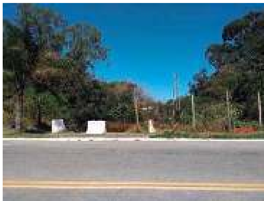
ausencia de parte do gradil - Parque Pinheirinho D' água Fonte: Fundação Aron Birmann
